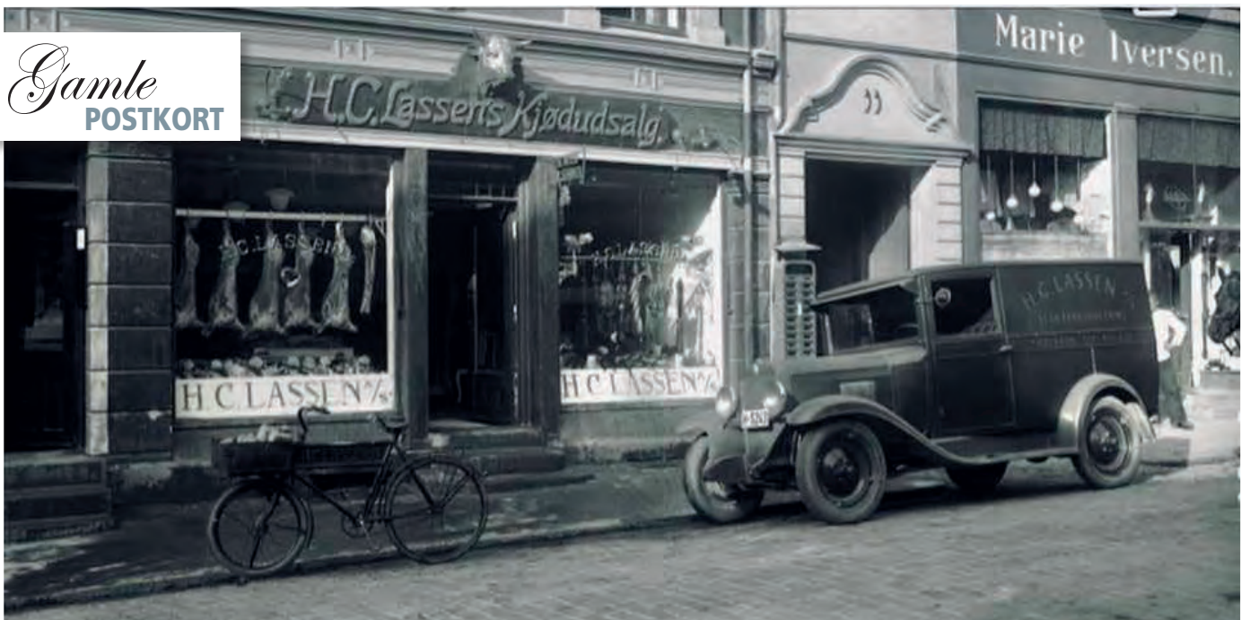
HC Lassen skal visstnok ha vore ein slakteributikk i Skien med godt gjennomført merking av både butikk og firmabil. Bilen er ein 1929 Chevrolet registrert på H-5267 utan at vi veit meir om denne.
